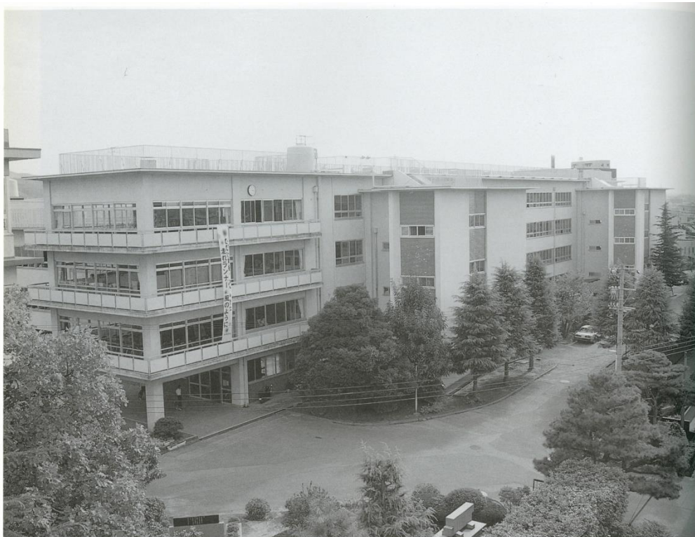
バランスドラーメン構造の鉄筋コンクリート造校舎で、当時の中学校建築計画の基本モデルとなった。
