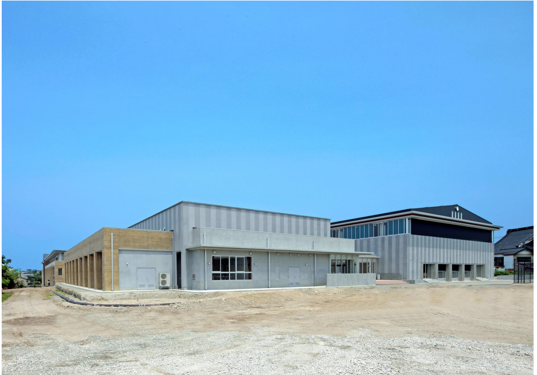
屋内運動場改築工事
