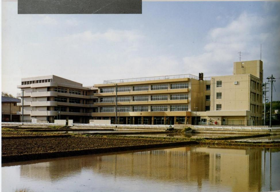
13 森本中学校 ● 弥勒町 校舎棟 ● 平成1年竣工 ● 鉄筋コンクリート造4階建 ● 7,326㎡
