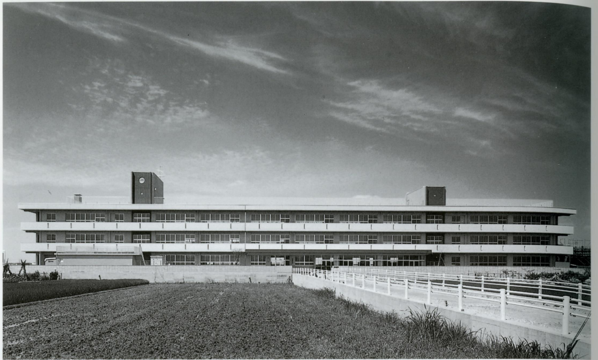
31 大浦町小学校 ●大浦町 校舎棟 ●昭和55年●鉄筋コンクリート造3階建●4,843m 2 体育館 ●昭和55年●鉄骨鉄筋コンクリート造2階建●1,582m 2
