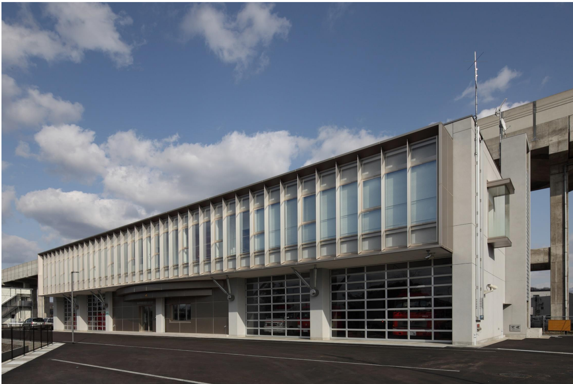
金沢駅西消防署小坂出張所(仮称)及び北部防災資機材備蓄施設新築工事
