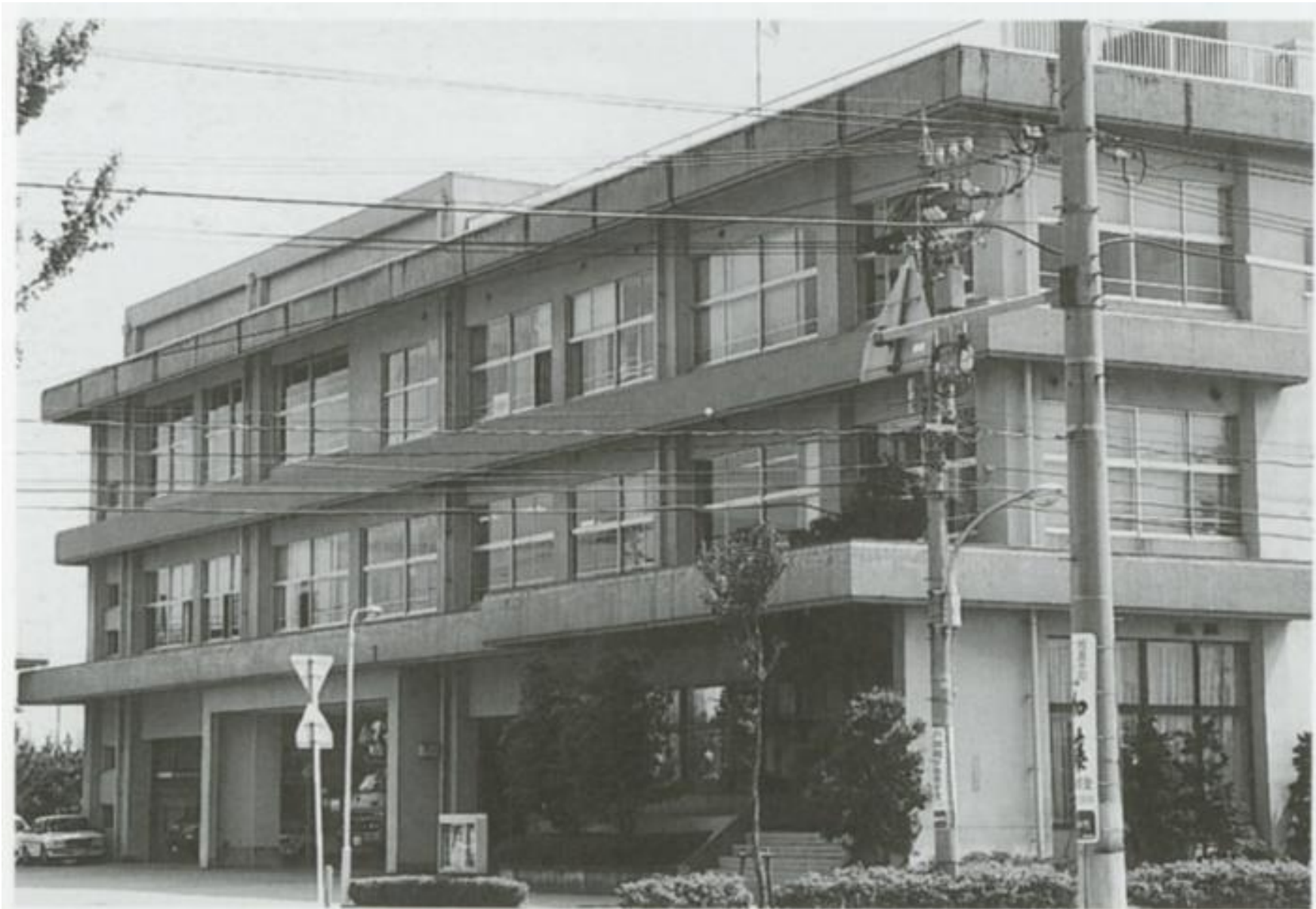
10 駅西消防署 ● 駅西本町1丁目 ● 昭和54年 ● 鉄筋コンクリート造3階建 ● 1,698m 2
