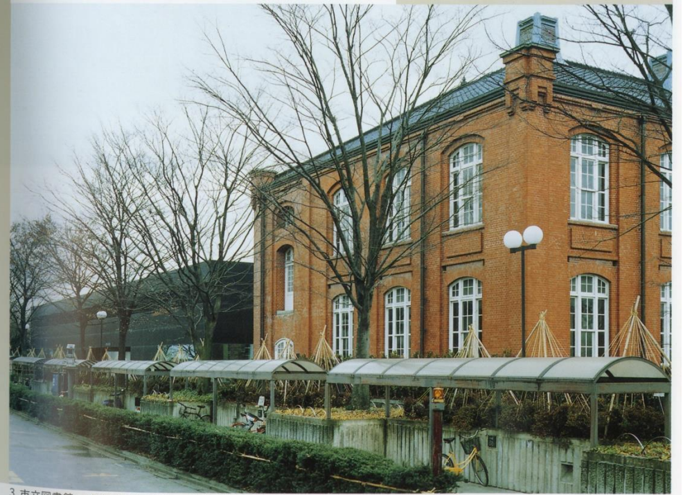
3 市立図書館 ●玉川町●昭和53年●本館 鉄筋コンクリート造(一部鉄骨造)地上2階、地下1階建●6,340㎡ 別館 煉瓦組積、鉄筋コンクリート補強、地上2階建
