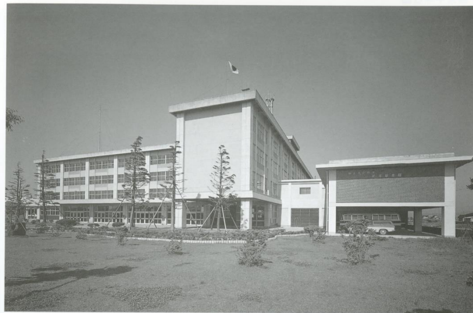
▲記念事業の際に建設された図書館棟 ●昭和43年 ●鉄筋コンクリート造 2階建 ●621㎡
