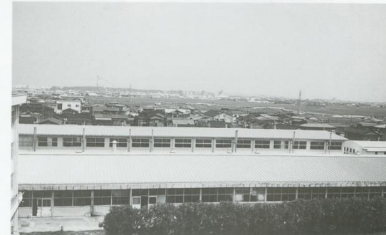
▼同窓会館 ●昭和53年 ●鉄筋コンクリート造 2階建 ●211㎡
