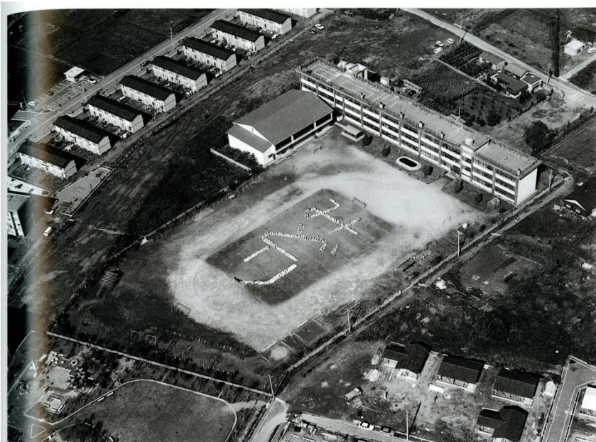
26 緑小学校 ●みどり1丁目 校舎棟●昭和38年～54年●鉄筋コンクリート造4階建●6,708㎡ 第1体育館 ●昭和39年●鉄骨鉄筋コンクリート造●549㎡ 第2体育館 ●昭和55年●鉄骨鉄筋コンクリート造●511㎡
