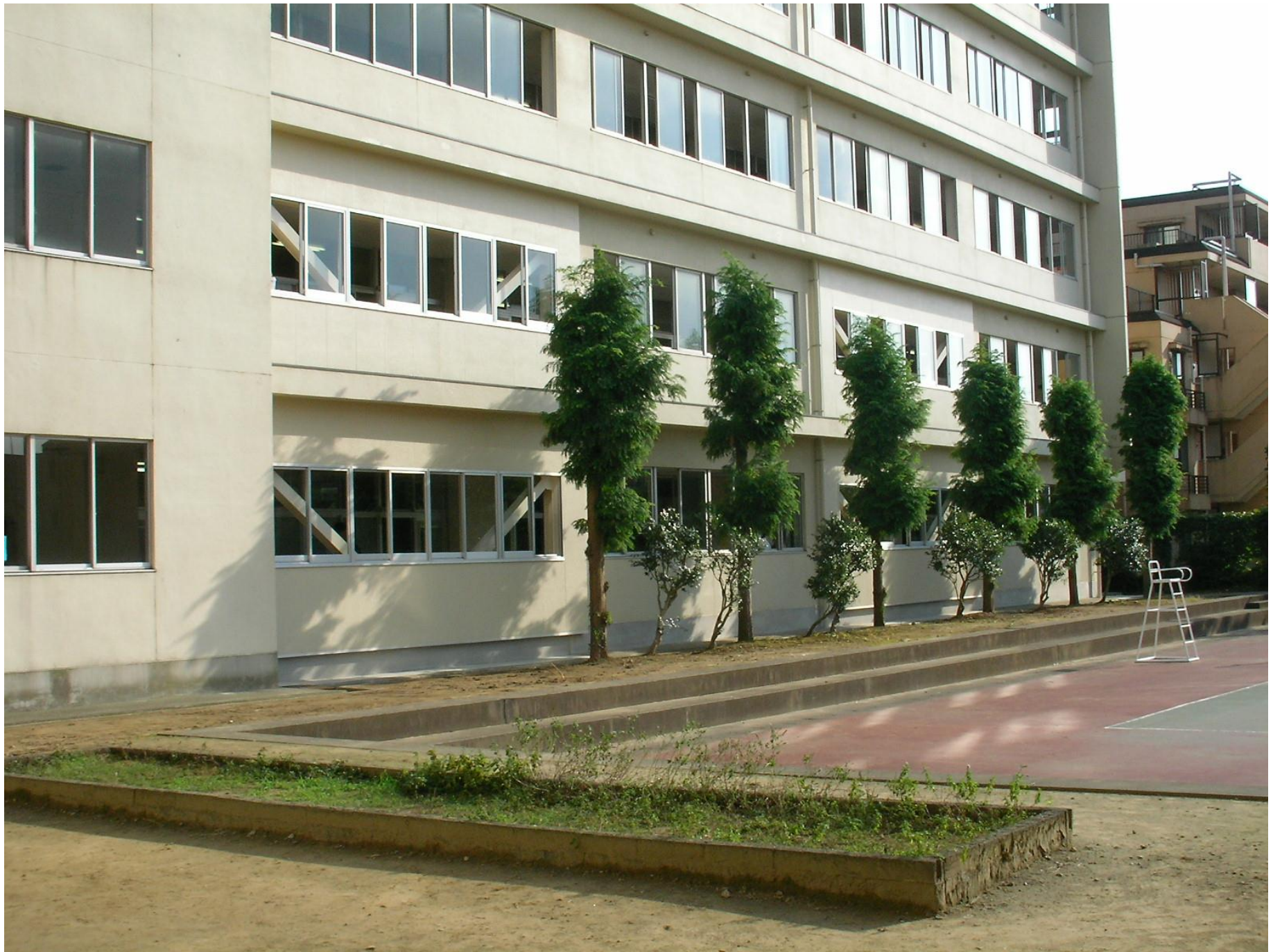
校舎耐震補強工事第1期、第2期、第3期
