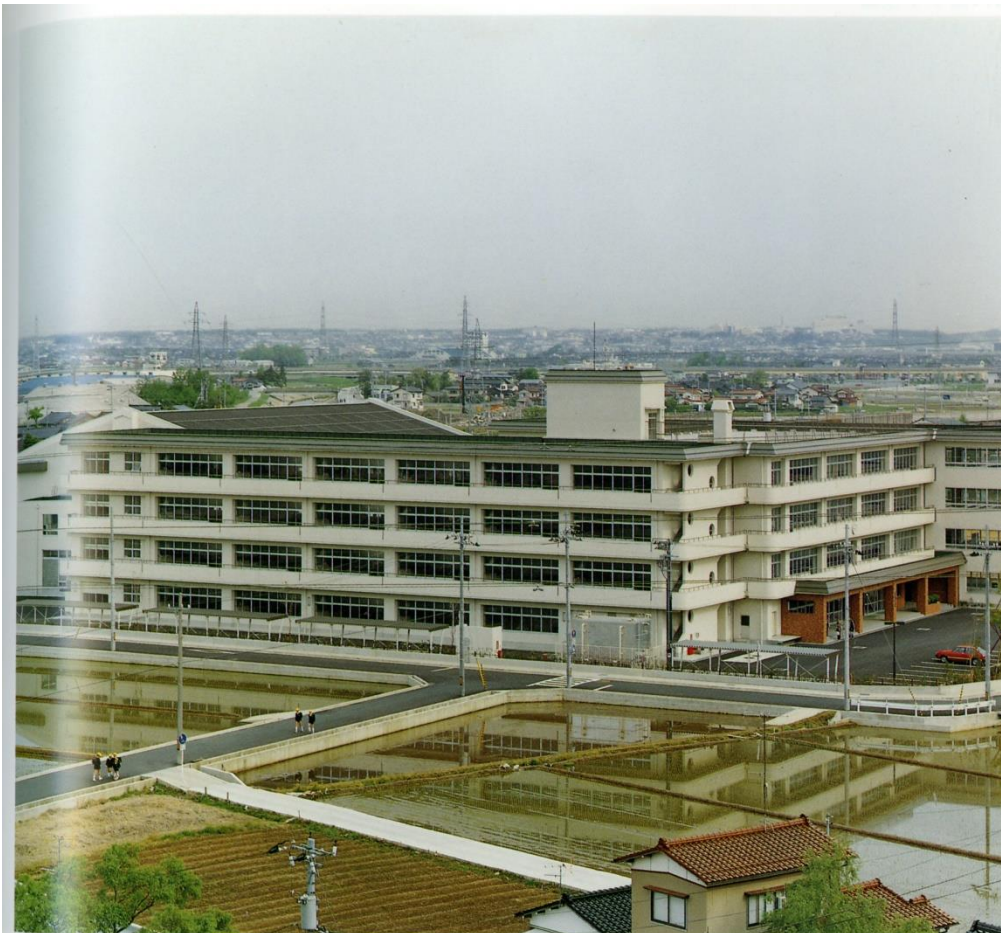
13 北鳴中学校 ●小坂町 校舎棟 ●昭和62年 ●鉄筋コンクリート造4階建 ●7,323㎡ 体育館 ●昭和62年 ●鉄骨鉄筋コンクリート造2階建 ●2,024㎡
