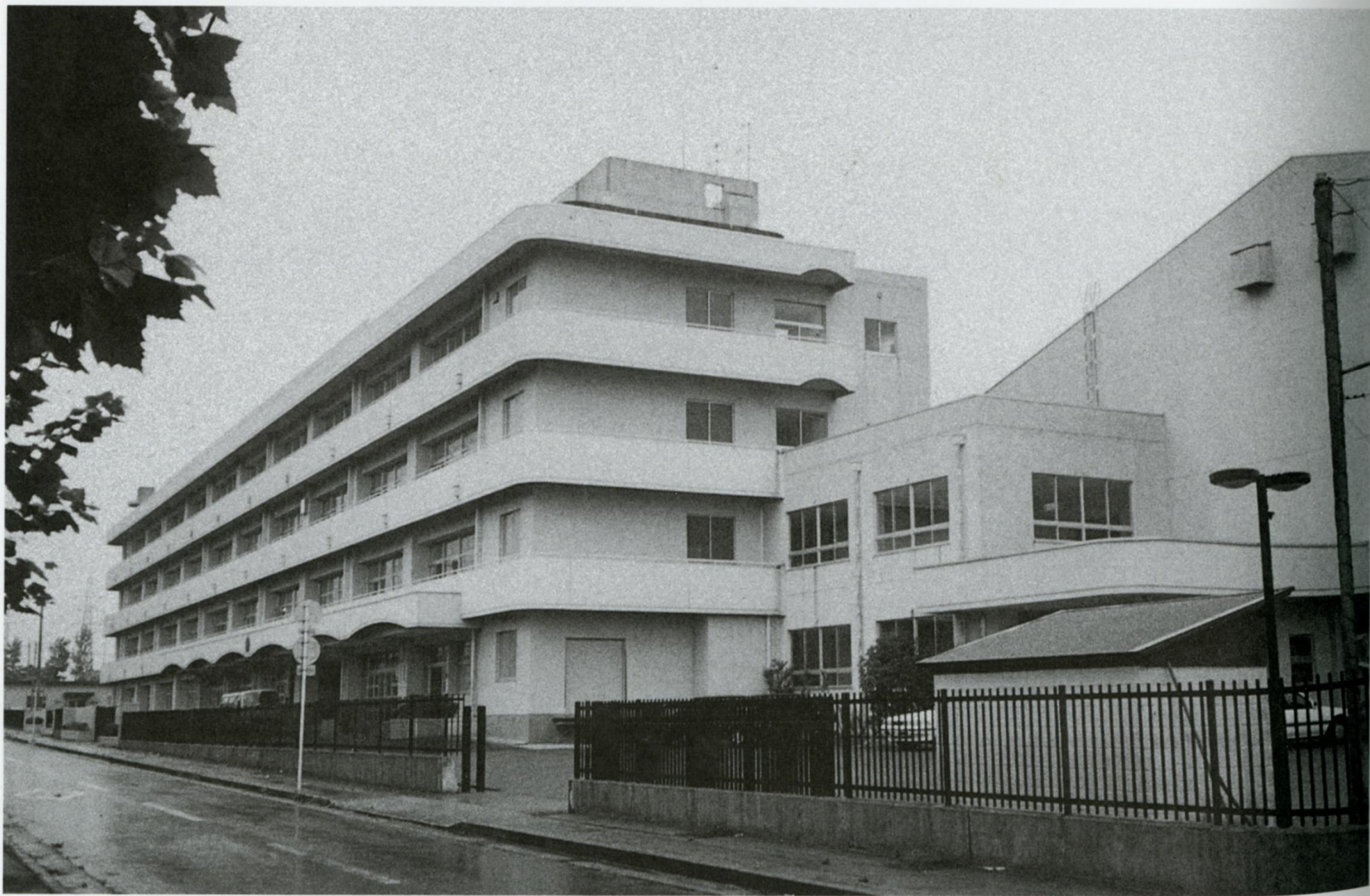
40 四十万小学校 ● 四十万3丁目 校舎棟 ● 昭和57年 ● 鉄筋コンクリート造4階建 ● 5,803m 2 体育館 ● 昭和58年 ● 鉄骨鉄筋コンクリート造 ● 917m 2
