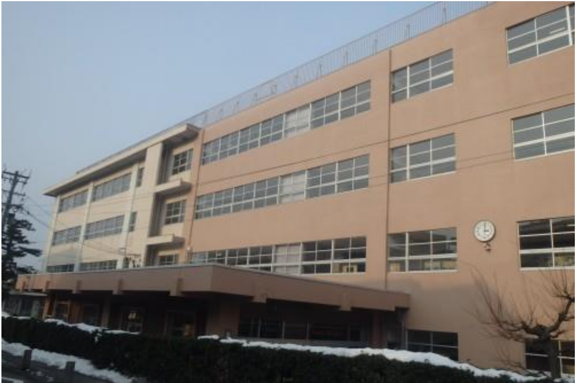
味噌蔵小学校校舎耐震補強工事第2期
