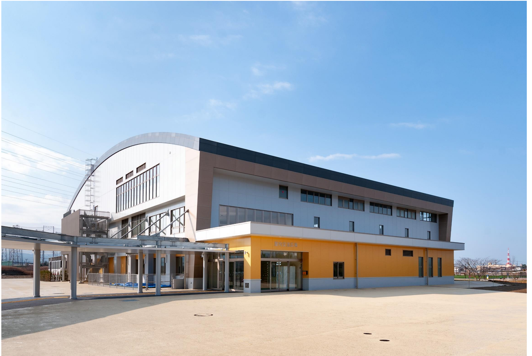
金沢市城北市民運動公園屋内広場建設工事
