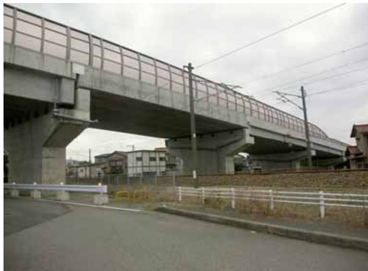
JR北陸本線との立体交差点
