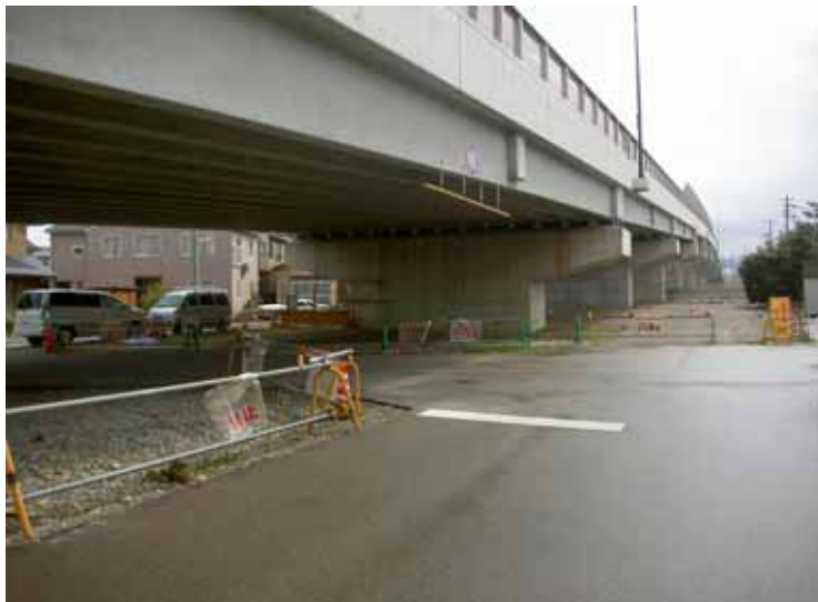
高架橋下部及び側道(八日市5丁目側)
