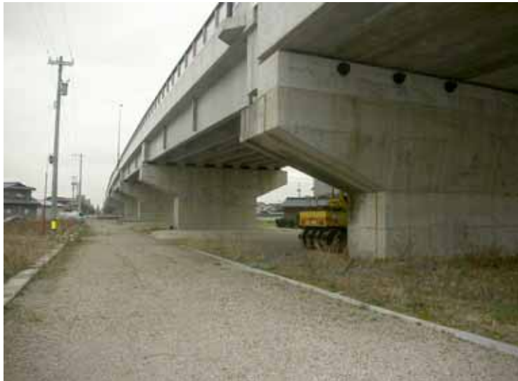
高架橋下部及び側道(押野2丁目側)
