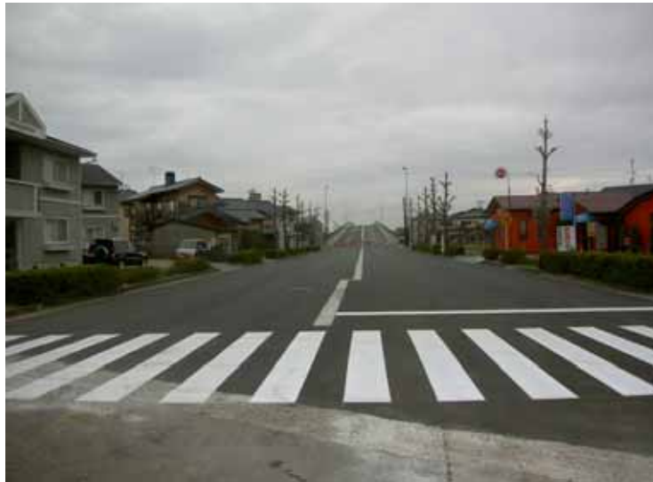
押野2丁目側から高架橋 (1)
