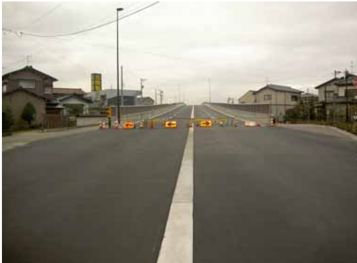
押野2丁目側から高架橋 (2)
